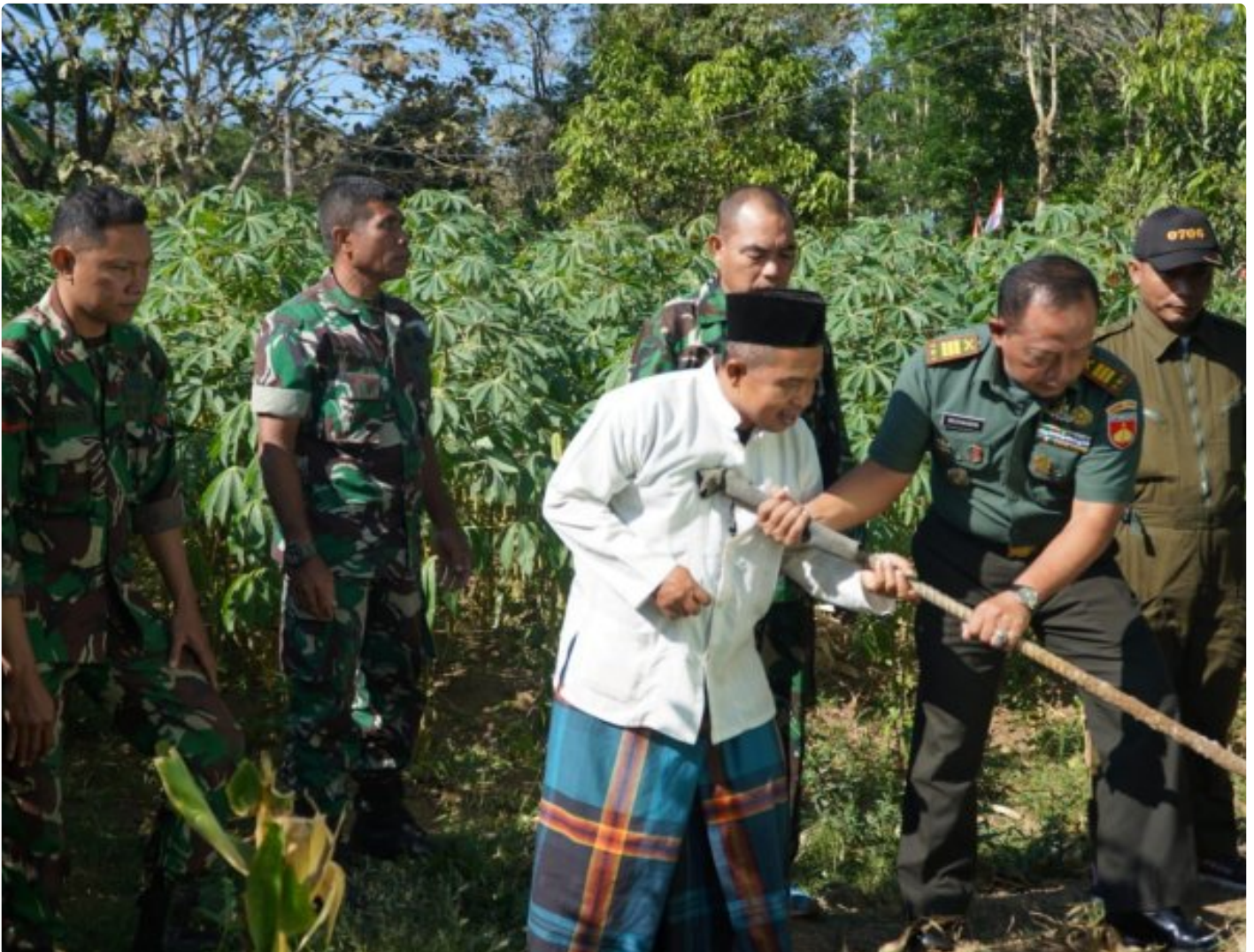
Foto : Kodim 0706/Tmg Melaksanakan Pelebaran dan Perbaikan Masjid Asrama
