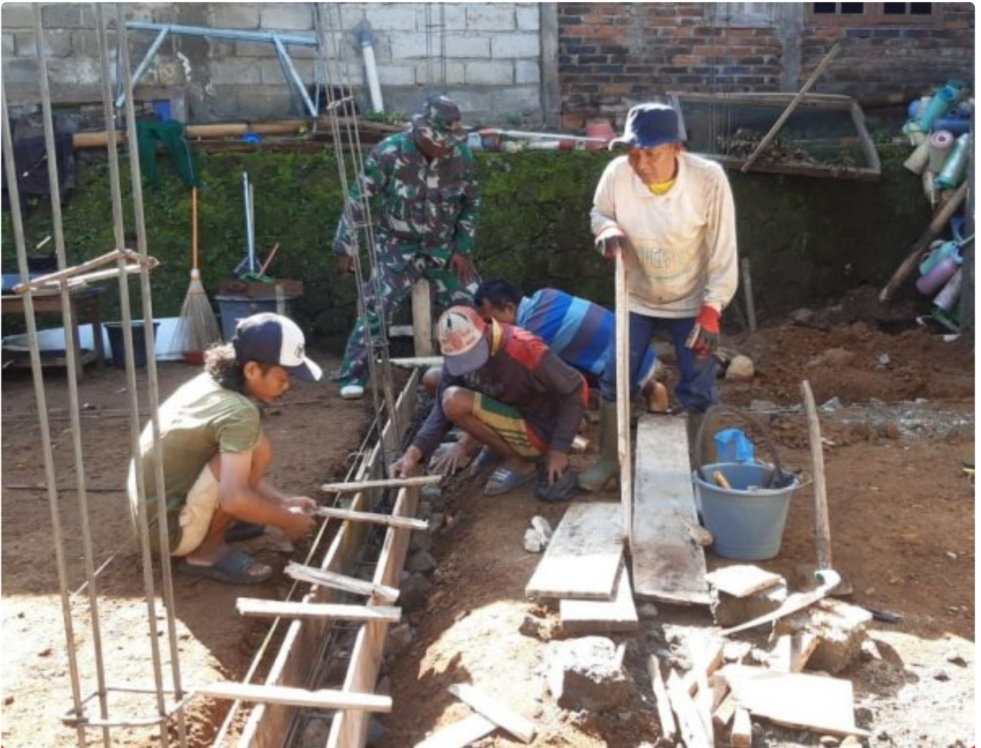
Pemasangan Bekisting Balok Sloof
