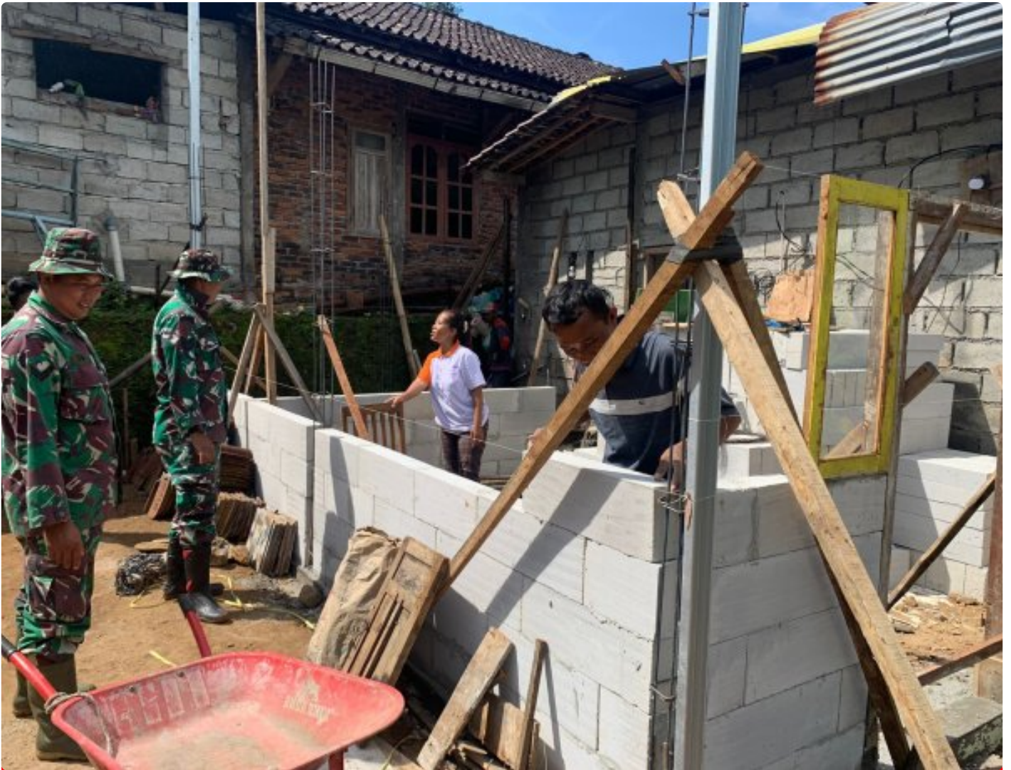
Pemasangan Dinding Menggunakan Herbel
